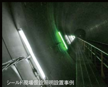
トンネル現場仮設照明設置事例
