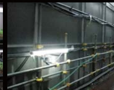
建築現場屋外設置事例
